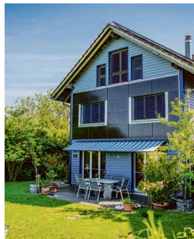
Classique : sur la façade solaire de la maison de Jegenstorf (BE) mentionnée dans l'article, les rayures typiques des modules PV sont encore visibles.
