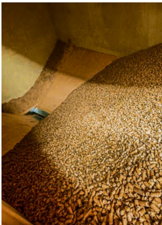
En voilà une autre nouveauté : le chauffage aux pellets au lieu du chauffage au mazout.
