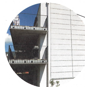
Les éléments photovoltaïques qui recouvrent cette façade s'adaptent aux exigences esthétiques. Réalisée par Solaxess sur la base d'une technologie CSEM. © DR
