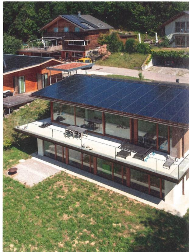
Situé à Boudry, ce bâtiment arbore quelques dizaines de mètres carrés de modules photovoltaïques qui s'harmonisent parfaitement avec le reste de la façade réalisée en crépis. Solaxess est désormais capable de proposer 3 coloris différents de panneaux pour façade: le blanc, le gris clair et le beige. [solaxess.ch](http://solaxess.ch)
